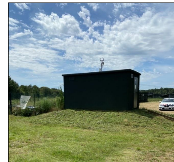
Figure 17 : Illustration d'un poste de livraison (Source : NEOEN)
