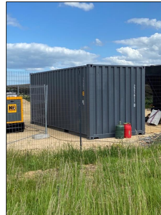
Figure 19 : Illustration d'un local d'exploitation (Source : NEOEN)
